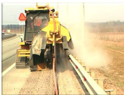
Рисунок 2 – Монтаж микро-траншей в асфальтном покрытии
