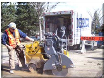
Рисунок 2 – Монтаж микро-траншей в асфальтном покрытии
