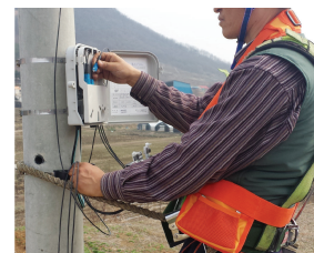
Использование системы ремней на столбе
