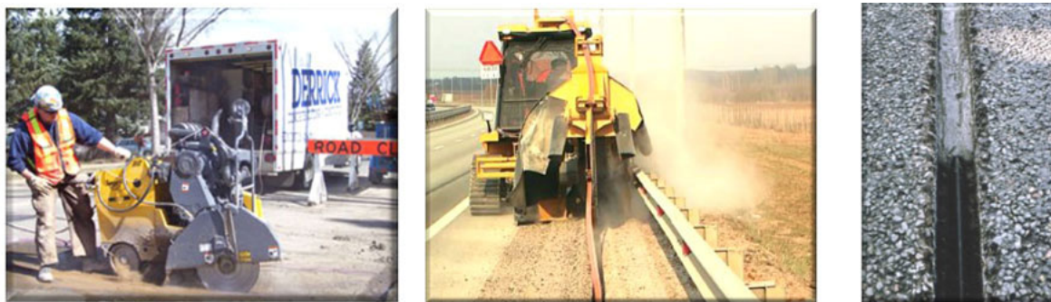
Рисунок 2 – Монтаж микро-траншей в асфальтном покрытии
