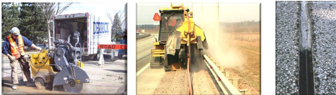
Рисунок 5 – Монтаж микро-траншей в асфальтном
