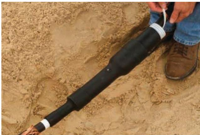
**Тип кабеля:** для одножильных кабелей с изоляцией из сшитого полиэтилена (СПЭ) и этиленпропиленовой резины (ЭПР) с медным проволочным экраном. Кабель может использоваться с ленточным медным экраном или экраном из алюмополимерной фольги. Обратитесь к представителям компании 3М для получения дополнительных инструкций.
