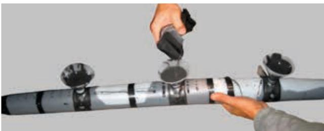
**Особенности монтажа:** Корпус муфты формируется из листа тонкого пластика, который при монтаже оборачивается вокруг срезка кабеля с последующей фиксацией и герметизацией лентами. В сформированный корпус компаунд заливается через воронки, входящие в комплект. Монтаж не требует огневых работ и специальных инструментов. Напряжение можно подавать сразу после окончания монтажа.
